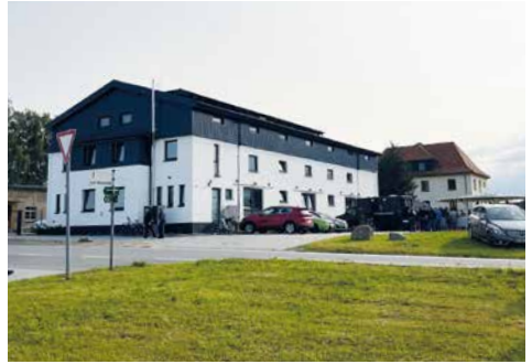
Das ehem. BHG-Gebäude nach dem Umbau Juni 2025
